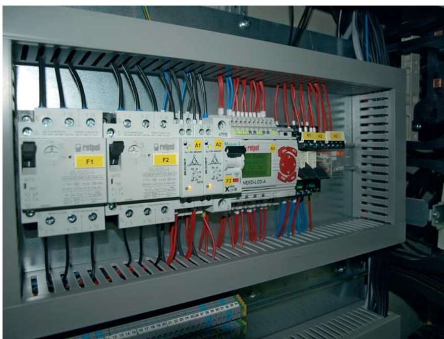
Rys. 1. Moduły automatyki produkowane przez firmę Relpol spełniają wszystkie warunki stawiane układowi SZR
